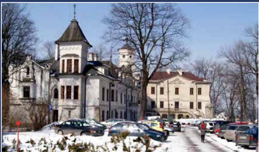
Stan obecny pałacu (2010 r.)
