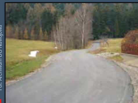
Nowa nawierzchnia asfaltowa - Kącina
