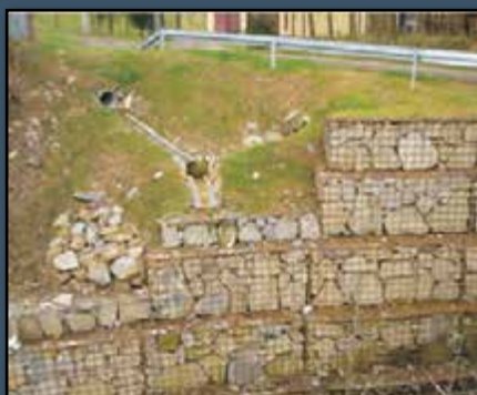
Umocnienie brzegu potoku przy drodze do Bączce-Kuniny
