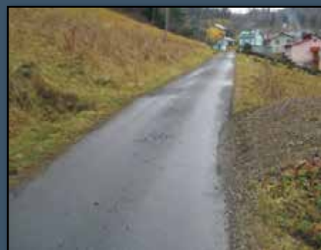
Wyremontowany odcinek drogi w Bączej-Kuninie
