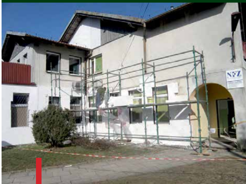
Prace remontowe Ośrodka
