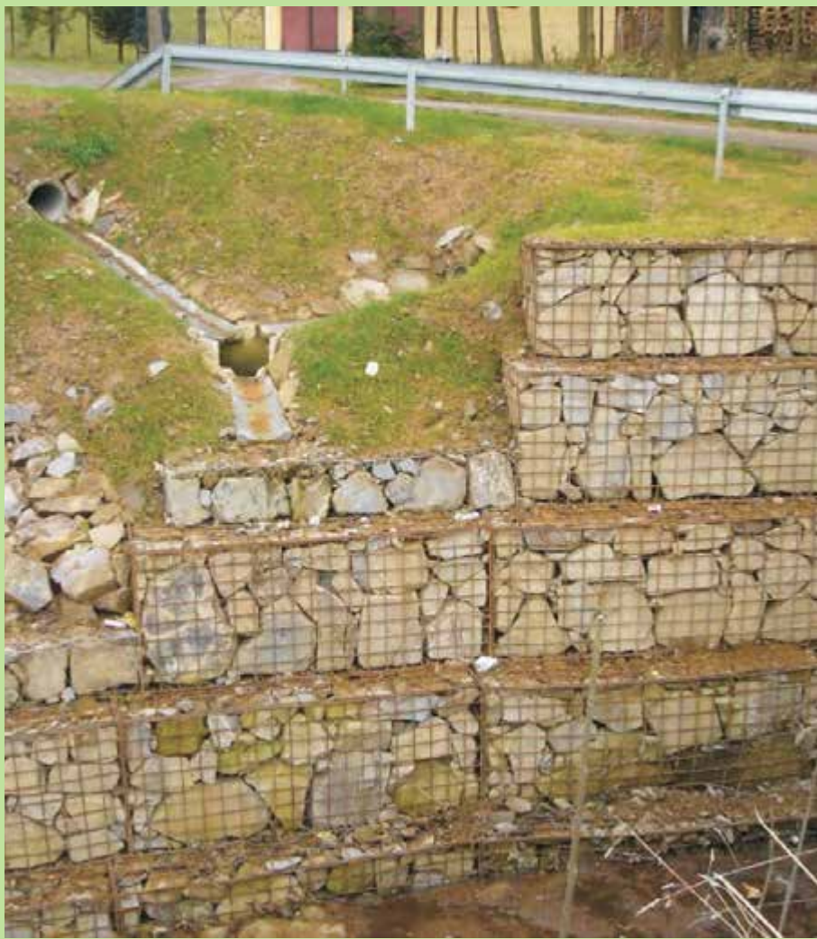
Umocnienie potoku przy drodze powiatowej na Bączą Kuninę
