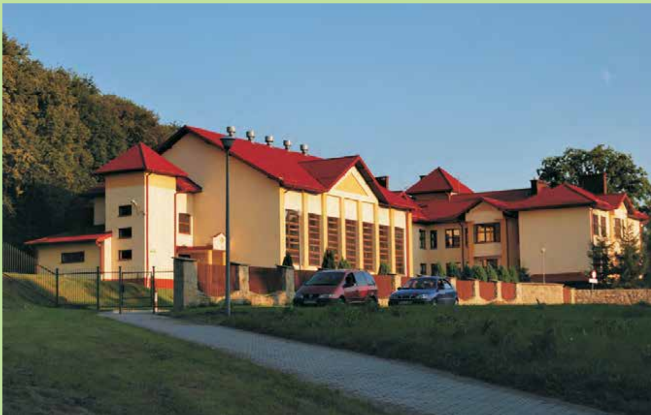
Budynek gimnazjum w Nawojowej
